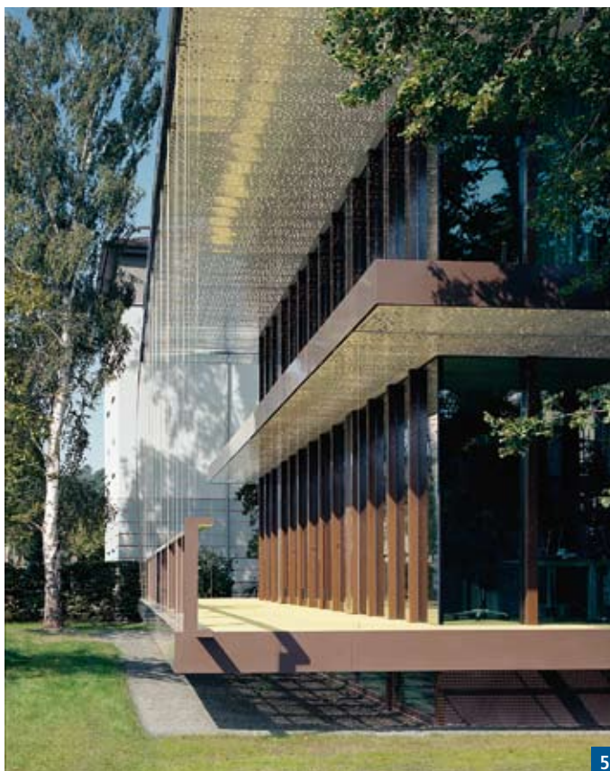
5 Begehbarer Balkonbereich im Erdgeschoss
