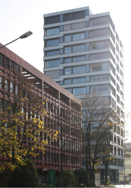
Ecke Baarer/Mattenstrasse von Norden gesehen | Coin Baarer/Mattenstrasse vu du côté nord
